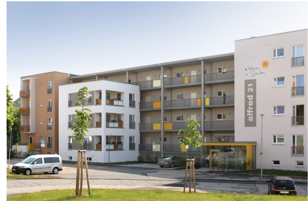
Abbildung : Umbau einer ehemaligen Schule zu Wohnungen. (Quelle: Jens Lönnecker, Architektenkammer Thüringen, https://architekten-thueringen.de/aft/projekte/p/wohnen_im_klassenzimmer___umbau_-3391.html )
