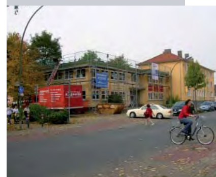
Friedrich-Ebert-Straße: Querungsstelle Fuß- und Radweg
