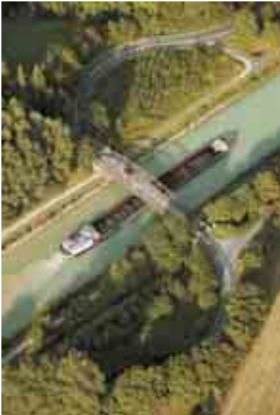
Abbildungen 4.5, 4.6: Kraftwerk Westfalen, Datteln-Hamm-Kanal Uentrop (Quelle: Blossey)
