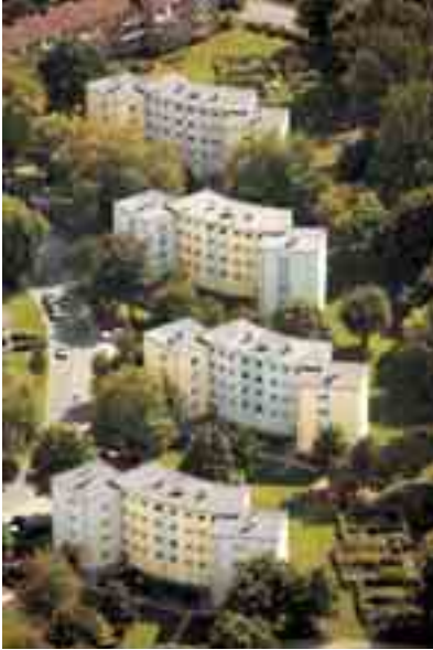
Abbildung 8.4: Wohnanlagen Schottschleife (Quelle: Blossey)
