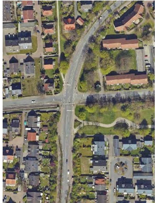
Abb. 50: Ostwennemarstraße / Kreuzung Grenzweg
