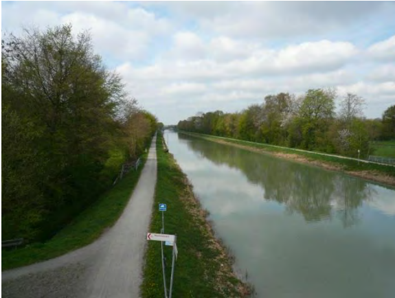
Abb. 38: Blick auf den Kanaluferweg von der Brücke Ostwennemarstraße
