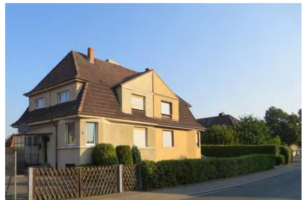
Abb. 18: Siedlungshaus in der Kolonie Maximilian
