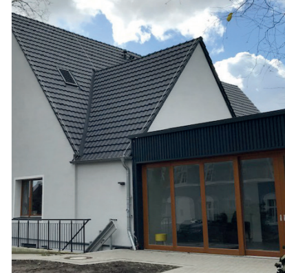
große Fensterfront des Anbaus
