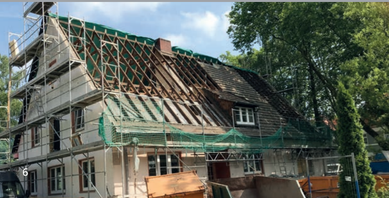
Vorbereitung der neuen Dacheindeckung
