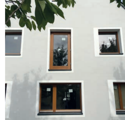
Fensteraustausch und Fluchttür
