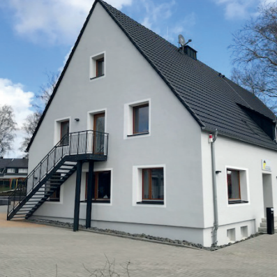
sanierte Fassade mit Fluchttreppe
