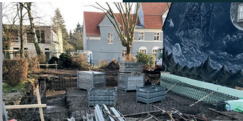
Vorbereitungen für den neuen Anbau
