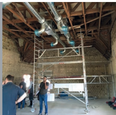
Einbau einer Lüftungsanlage
